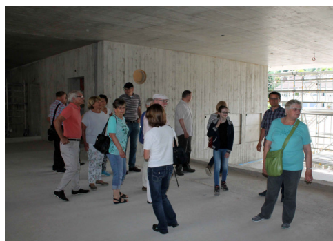
Rohbau Schulhaus Wilmatt
